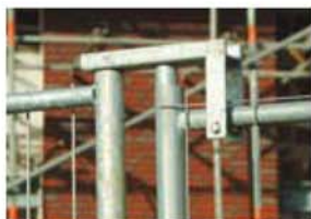
Hængselssæt. Bruges til at lave svingport med.
