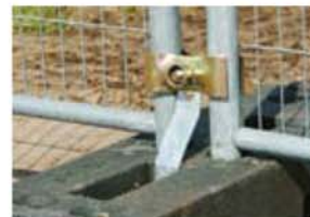
Antiløft anordning. Forebygger at hegnet kan løftes op.
